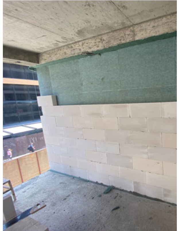
4 - Keçe arada kalacak şekilde ikinci sıra duvar örülür ve bitirilir.
