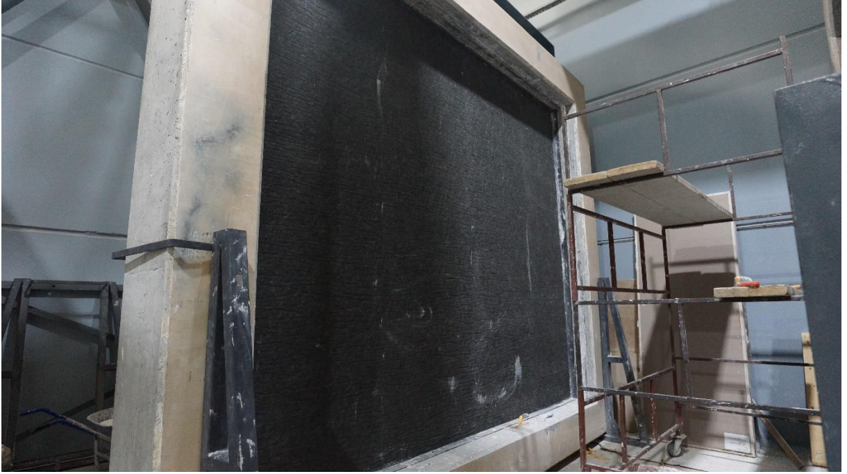
Şekil 3.7 İzobozz Polyester Elyaf 15mm Keçe Uygulaması
