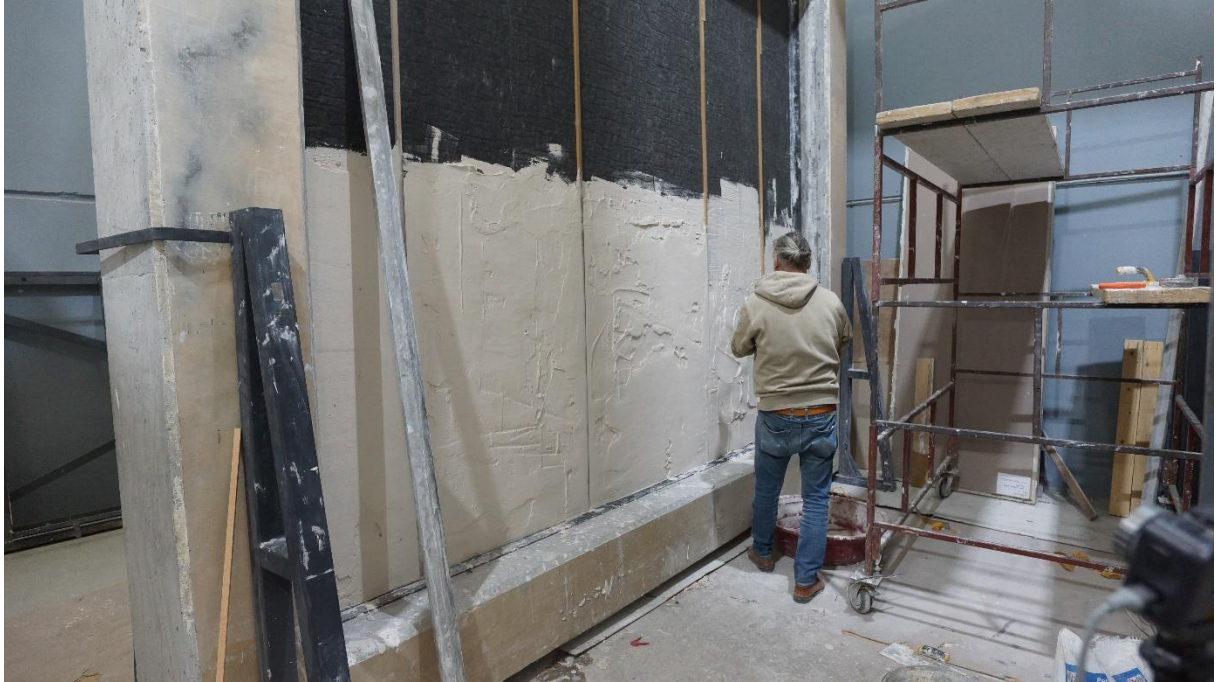
Şekil 3.9 İzobozz Polyester Elyaf 15mm Keçe Üzeri Alçı Sıva Uygulaması
