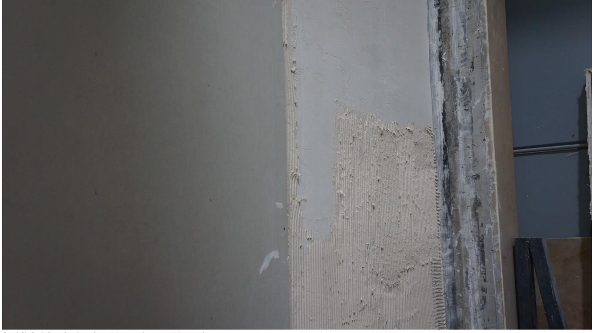
Şekil 3.10 Alçılevha Yapıştırma Uygulaması
