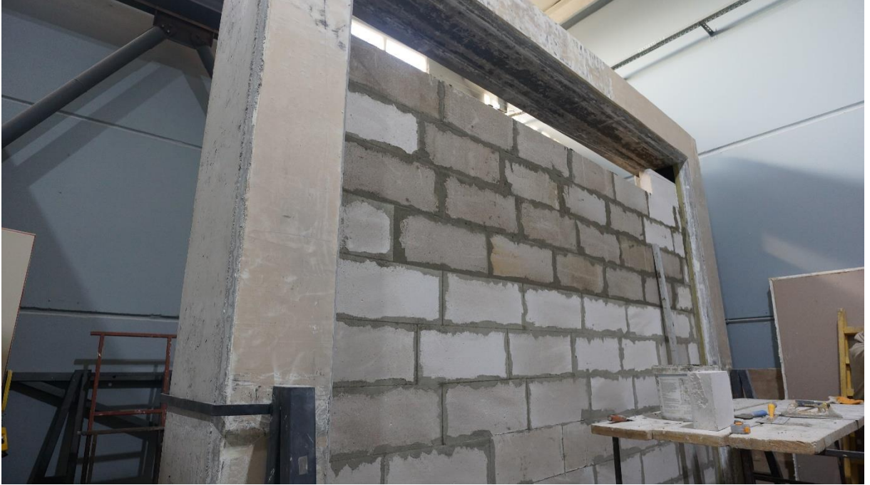
Şekil 3.5 Duvar Örne Detayı
