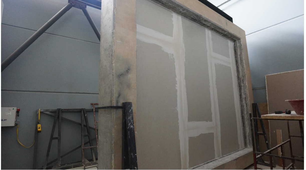
Şekil 3.11 Duvar Nihai Fotoğrafi
