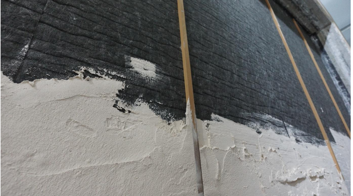
Şekil 3.11 İzobozz Polyester Elyaf Keçe Üzeri Alçısiva Uygulaması Detayı
