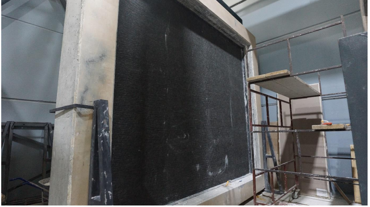
Şekil 3.8 İzobozz Polyester Elyaf 15mm Keçe Uygulaması
