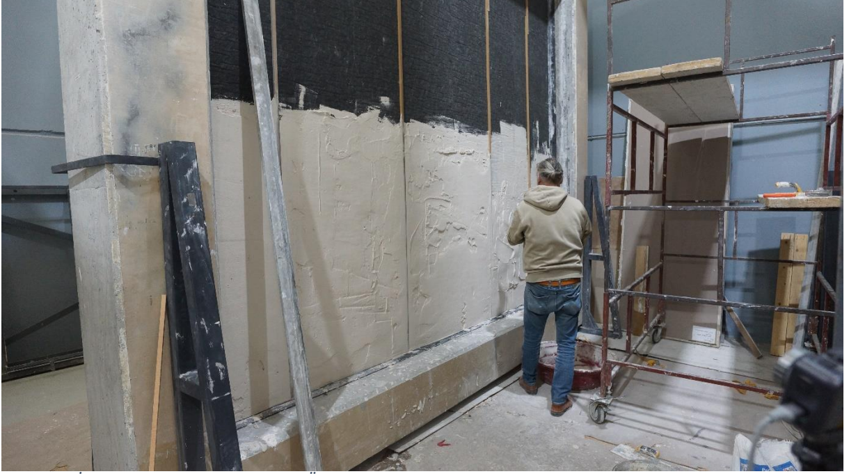
Şekil 3.10 İzobozz Polyester Elyaf Keçe Üzeri Alçısiva Uygulaması
